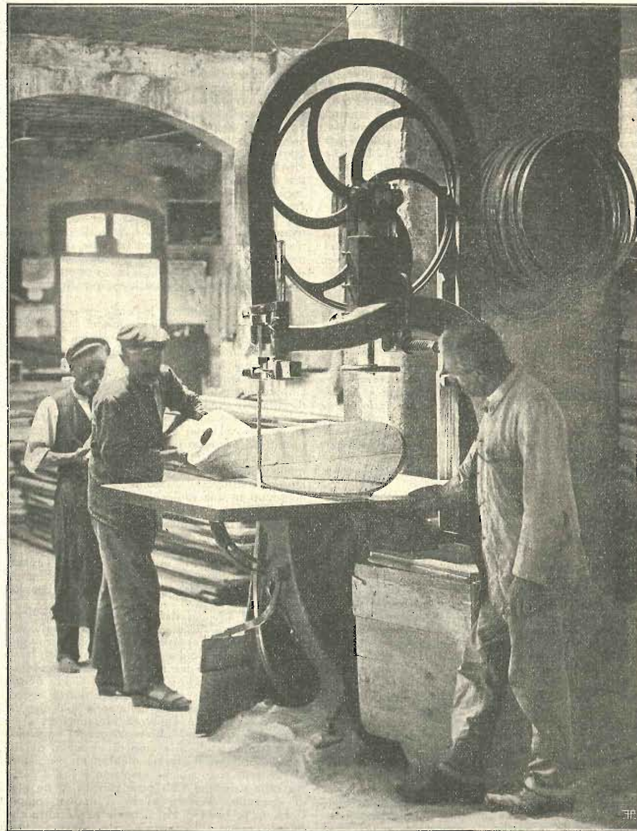
Alle Officine Caproni di (Cesura) - Lavorazione dell'elica.
